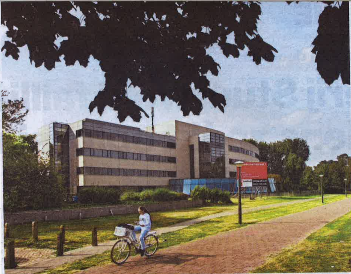
▲ Het kantoorpand aan Beukenlaan/Tilburgseweg waar een deel van het Stercollege en School23 in gaan zitten. FOTO RENÉ MANDERS/FOTOMEULENHOF
